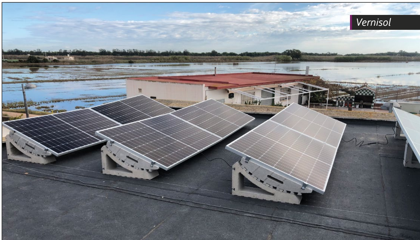
VERNISOL soporte patentado para paneles solares. Fácil instalación en suelo y cubiertas sin perforaciones.
